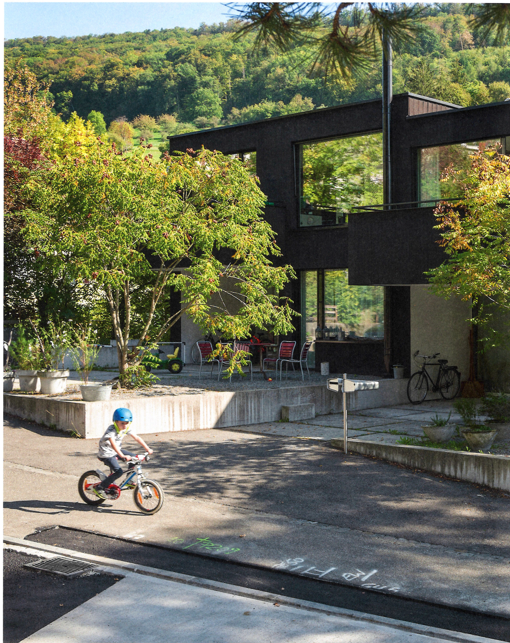
18.09.2018, Trottenstrasse 5, 5408 Ennetbaden, Baujahr: 2012, Architektur: BEM Architekten AG, Baden
